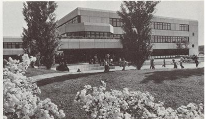
Der Neubau des Scheffel-Gymnasiums
