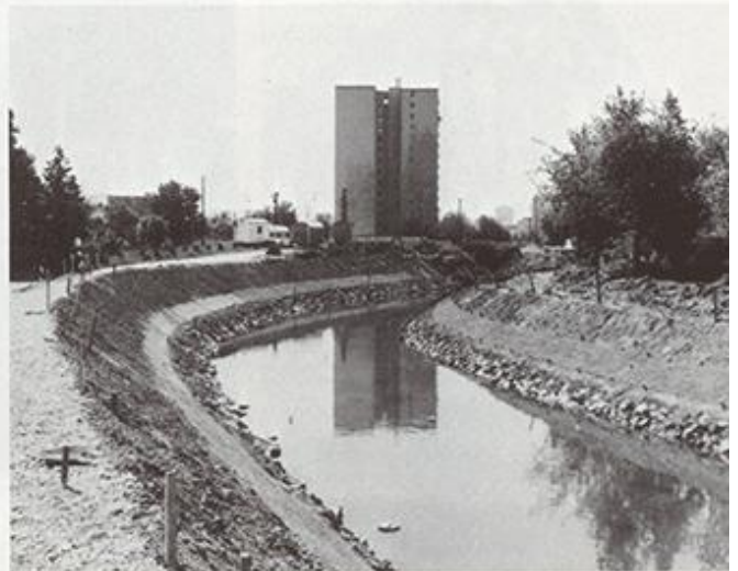
Hochwasser-Sicherung am Schutterufer
