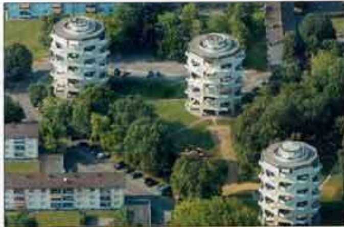
Die Städtische Wohnbau hat einen Ideenwettbewerb für den Kanadaring gestartet. Die ersten Entwürfe liegen vor. Foto: Keiper
