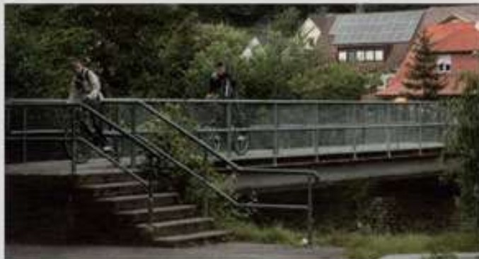
Das »Brückle« steht in Dinglingen als nächstes an.
